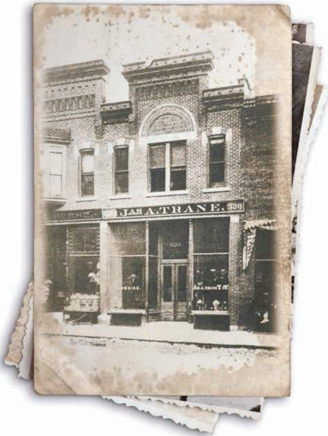
Magasin Trane La Crosse (Wisconsin) 1891 Photo : Archives de la bibliothèque publique de La Crosse (Wisconsin)
